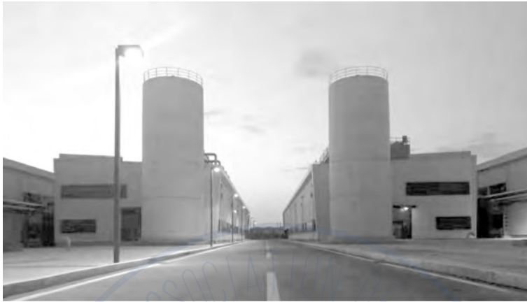
图 6.1-4 紧邻的制冷站
