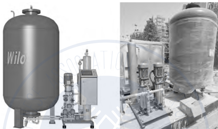
图 5.4-1 威乐定压补水真空脱气装置图
