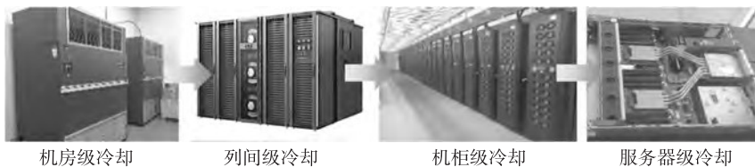
图 2.2-1 数据中心冷却层级
