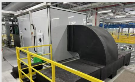
喷漆烘干段 - 油漆烘干冷热联用
