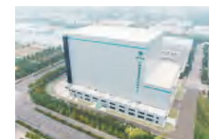
\pm 1100\text{kV} 特高压绝缘试验大厅
