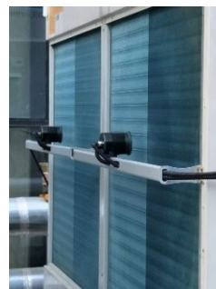
图 69 离心雾化装置与改造后的机组室外机
