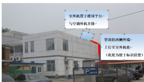
图 9 数据中心整体图
