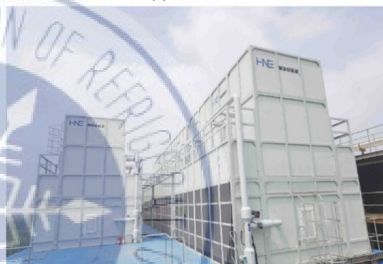
(b) 间接蒸发冷却冷水机组
