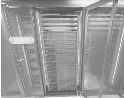
图 10.1-21 液冷机柜
