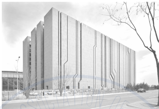
图 10.1-29 数字北京机房外观照片
