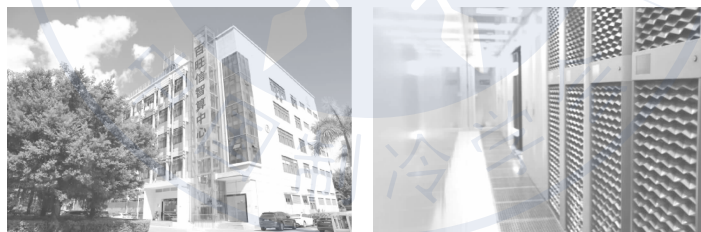
(a) 深圳百旺信智算中心外观照片 (b) 深圳百旺信智算中心机房照片
