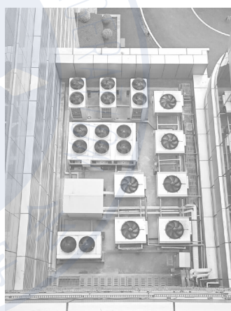
图 10.1-35 室外干冷器散热模组
