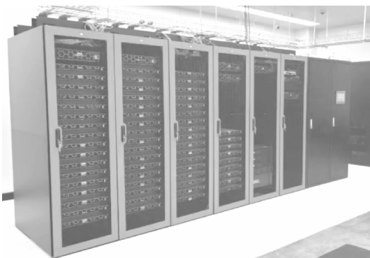
图 9.3-2 机柜式芯片冷却 CDU 实物图
