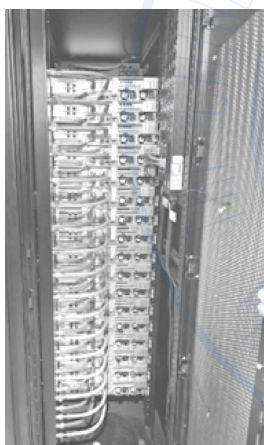
图 10.1-34 芯片级两相液冷系统
