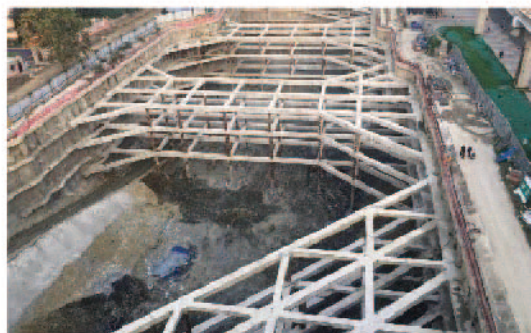
保利时代2号地块基坑工程
