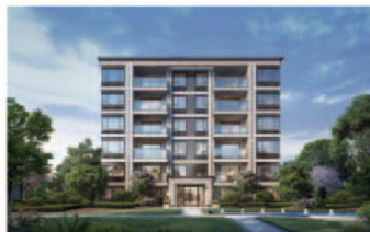
项目名称：金隅·金成府 施工内容：基坑支护及降水 工程地点：成都市高新区崇和二街555号
