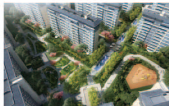
项目名称：碧桂园·锦官天宸 施工内容：基坑支护 工程地点：成都市简阳市爱晚路1069号
