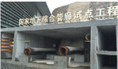
六盘水市地下综合管廊
