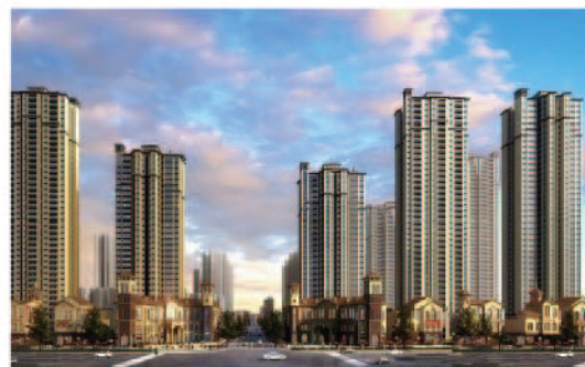
蓝光·乐彩城基坑护壁工程
