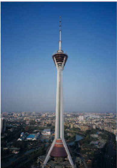
四川电视塔勘察
