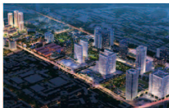
项目名称：建发·央玺 施工内容：基坑支护 工程地点：成都市锦江区三圣乡花果村一组沙河堡南3A3B地块
