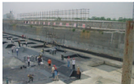
华润·凤凰城基坑工程
