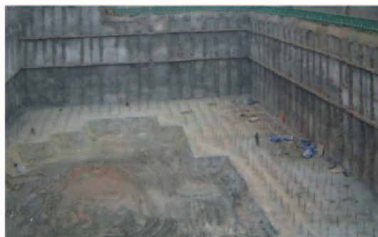
中汇广场二期护壁工程
