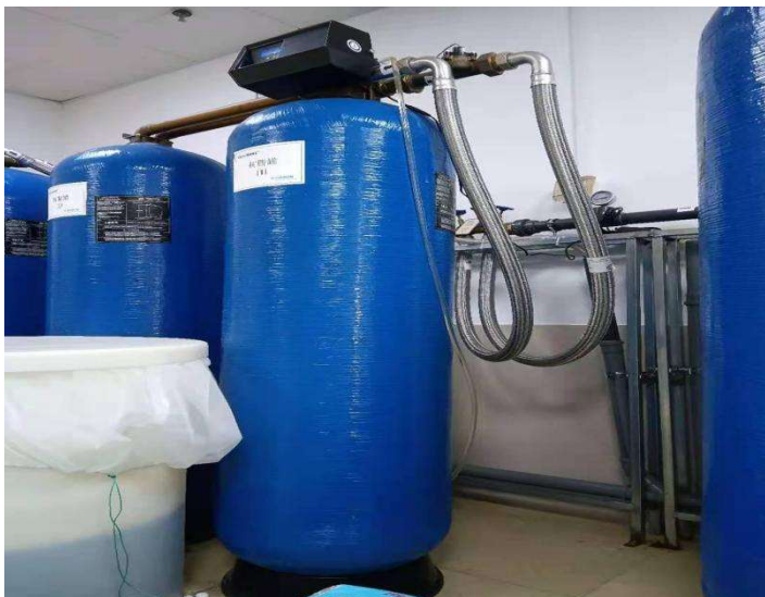
图 2.3 树脂罐与盐缸的外观图
