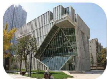
油藏描述重点实验室实验大楼
