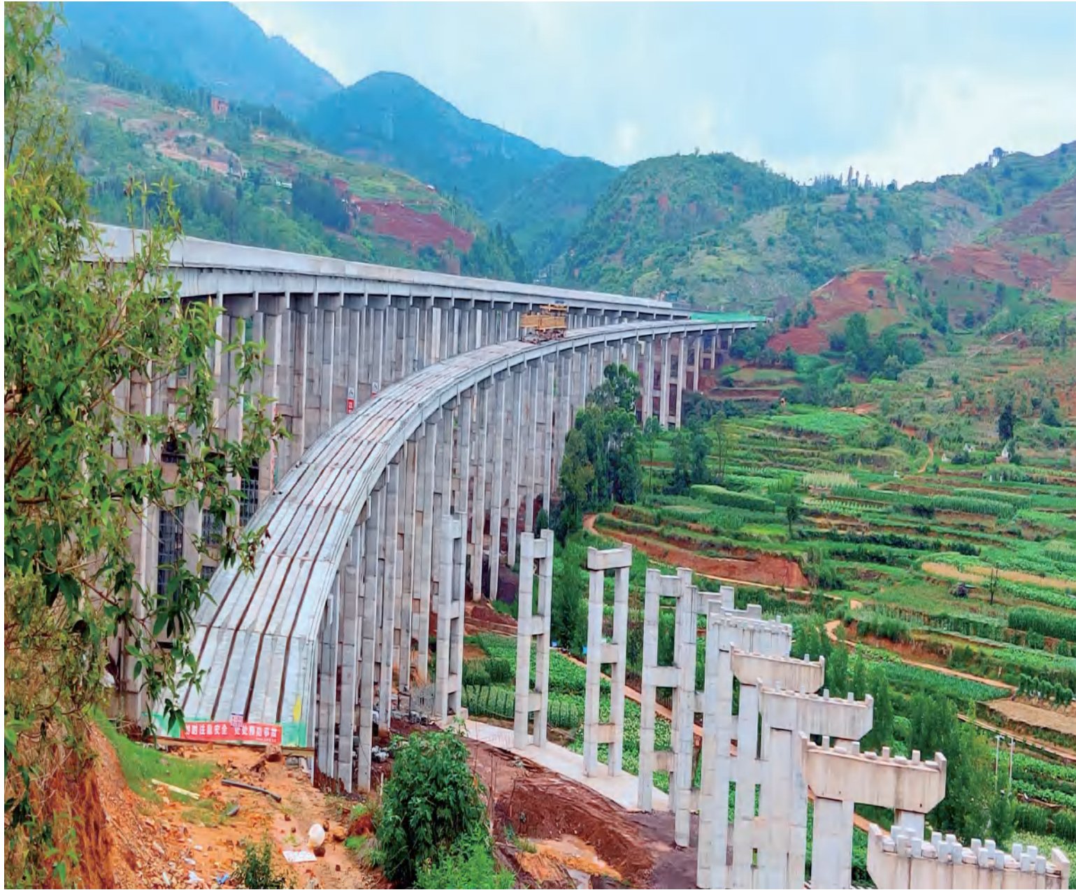
云南省弥玉高速项目 Yunnan Miyu High-speed Project
