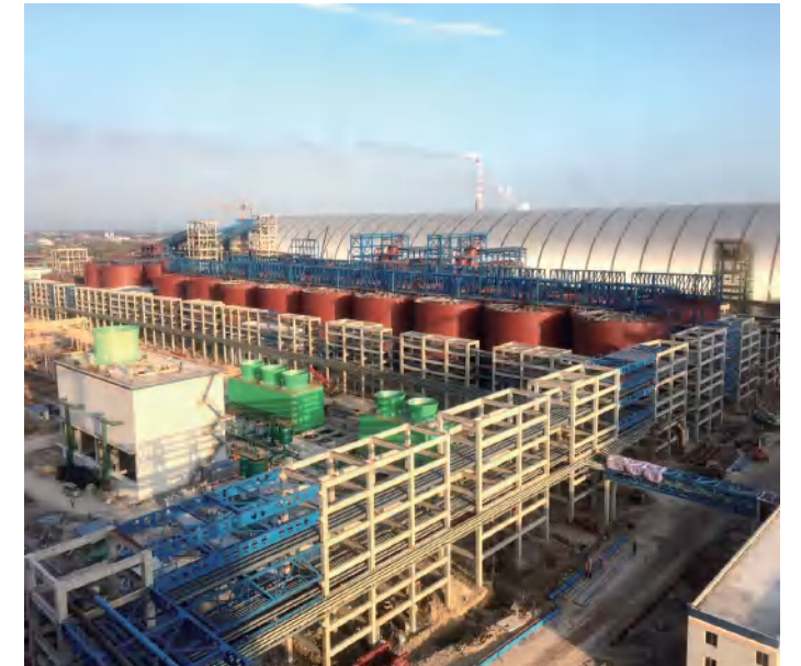
广西华昇氧化铝综合管网工程 Guangxi Huasheng alumina comprehensive pipe network project
