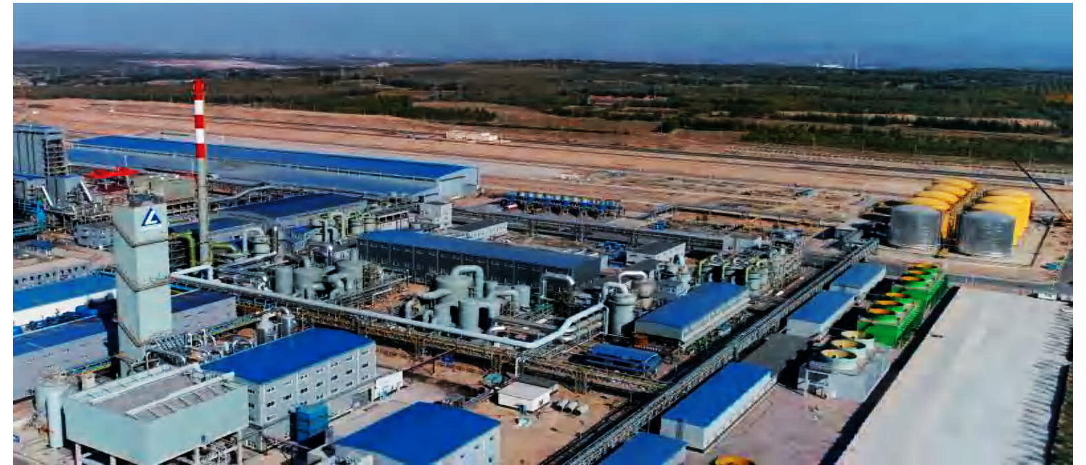
中铝赤峰云铜800kt/a硫酸工程 Chalco Chifeng Cloud copper 800kt/ A Sulphuric acid Project
