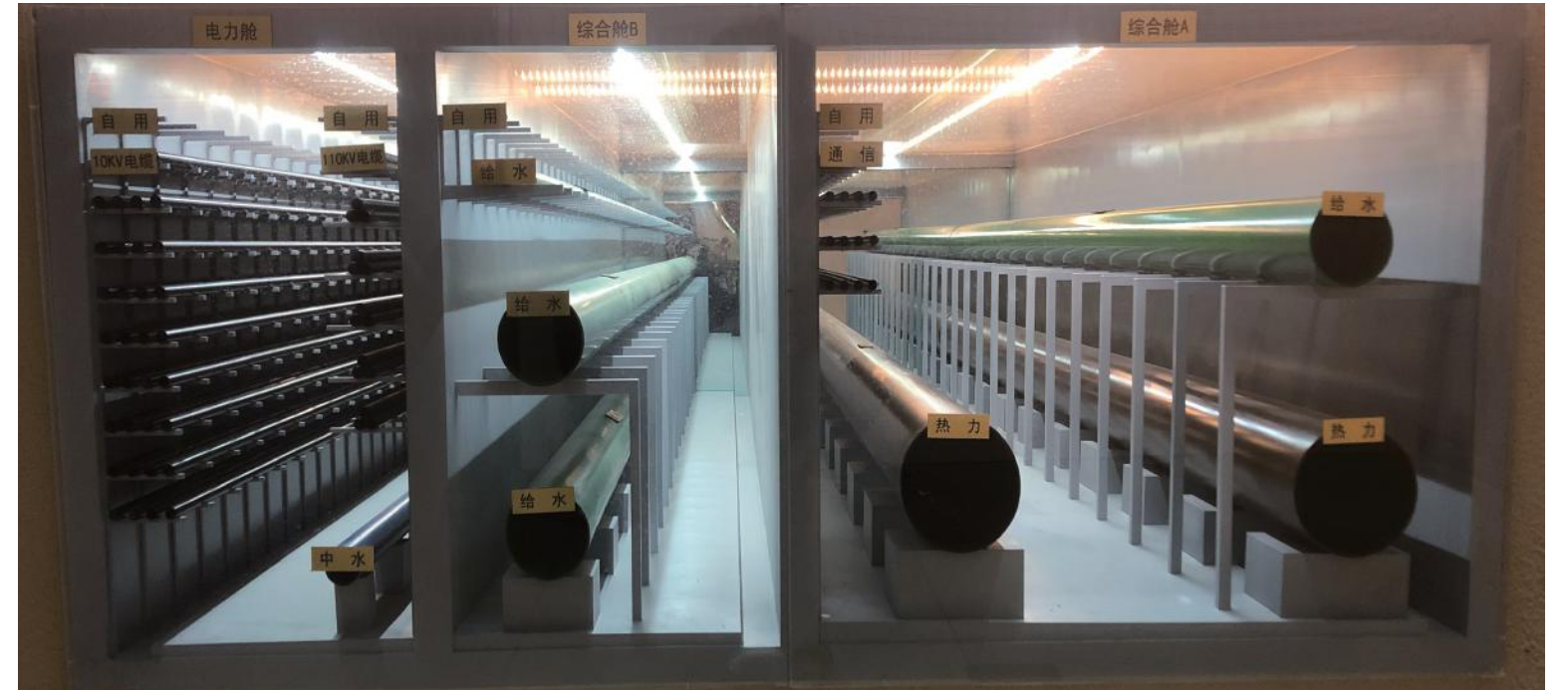
铜川管廊工程 Tongchuan Pipe Gallery Project
