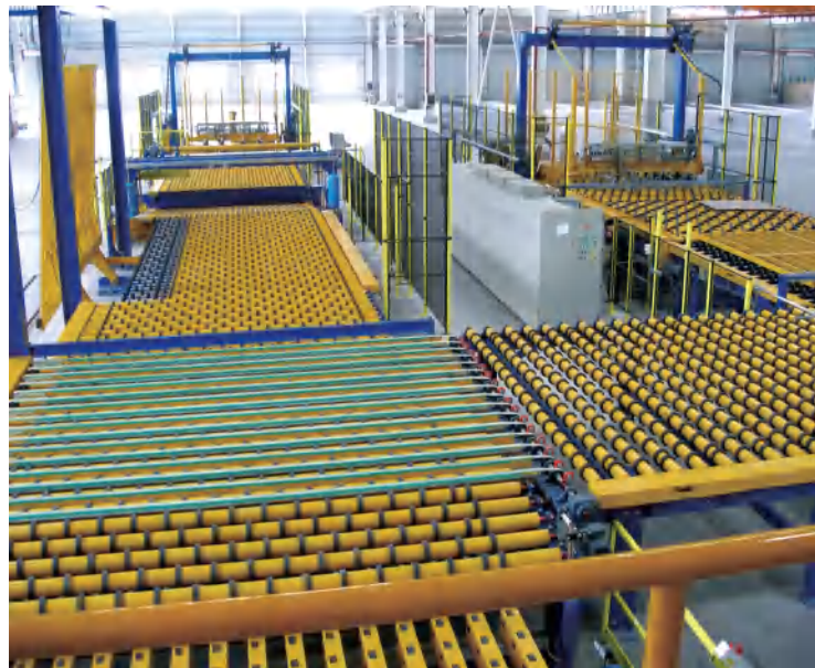
阿尔及利亚LARBA浮法玻璃厂 LARBA Float Glass Factory, Algeria
