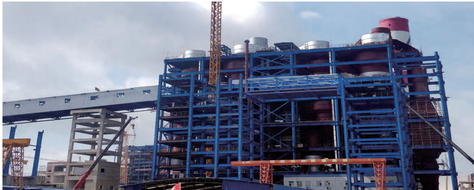
广西华昇氢氧化铝焙烧工程 Guangxi Huasheng Aluminum hydroxide roasting project
