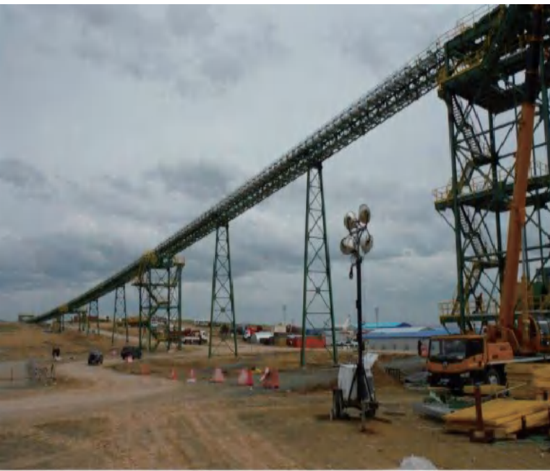
哈萨克斯坦铜矿项目 Kazakhstan Copper Mine Project
