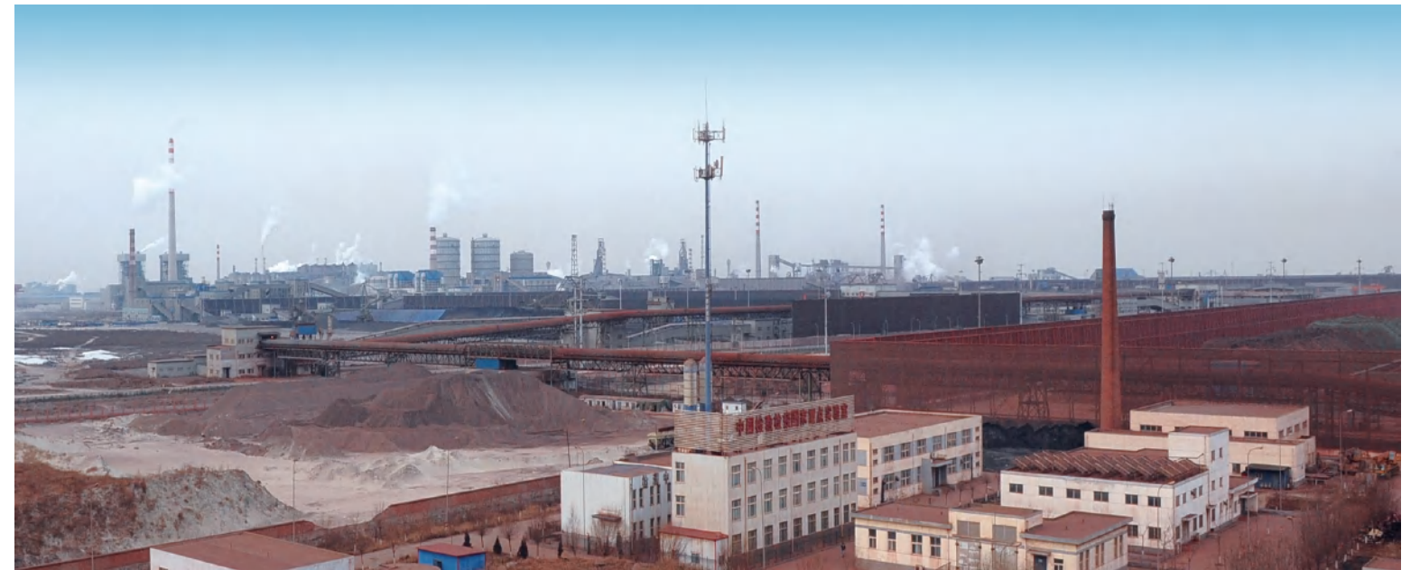
首钢京唐钢铁联合有限责任公司项目 Shougang Jingtang Steel Joint Co. LTD. Project
