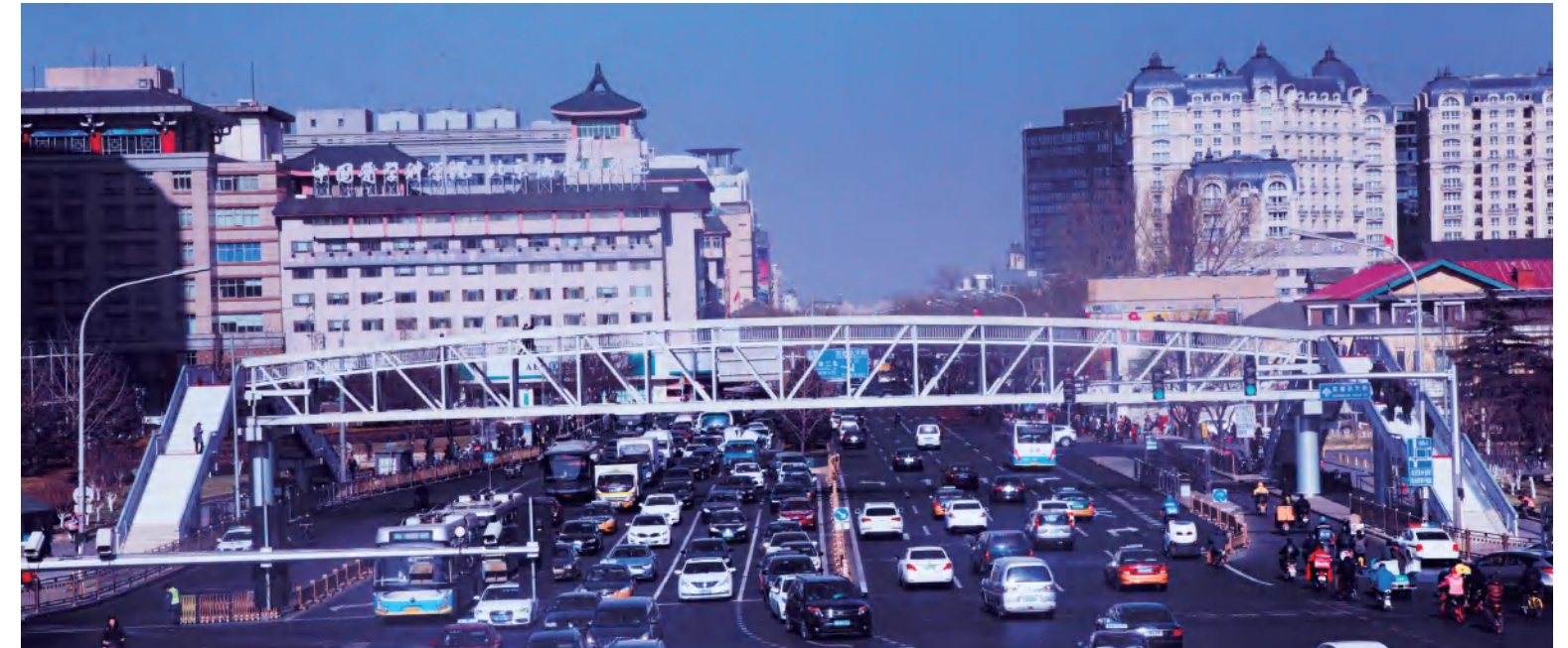
北京市东单铝合金天桥 Dongdan aluminum alloy overpass in Beijing 东单北铝合金天桥是国内跨度最长的铝合金天桥，结构新颖、造型美观，具有耐腐蚀性强、绿色环保等优点
