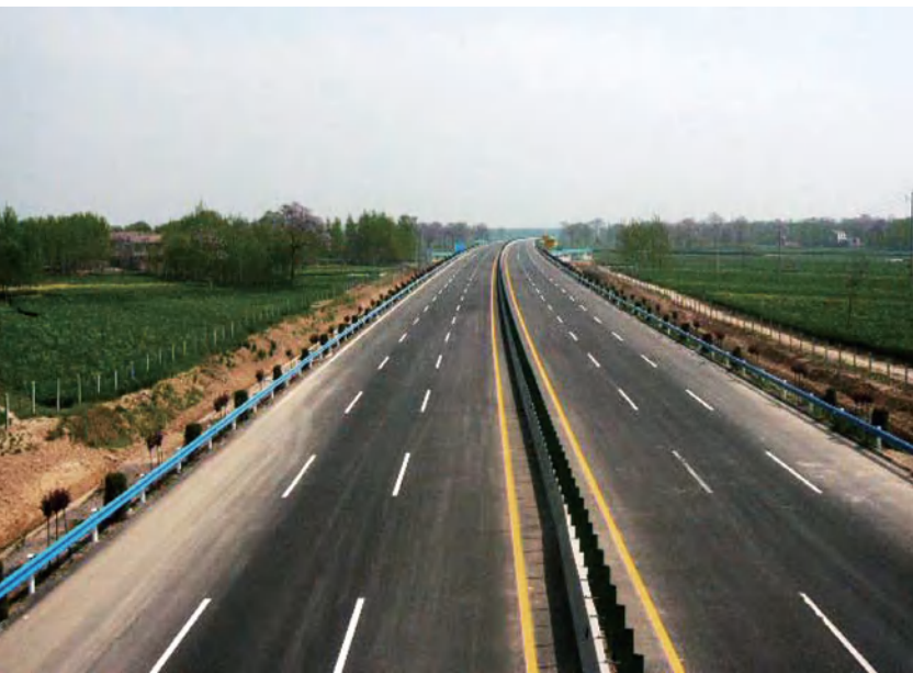
河南商周高速公路 Henan Shangzhou Expressway
