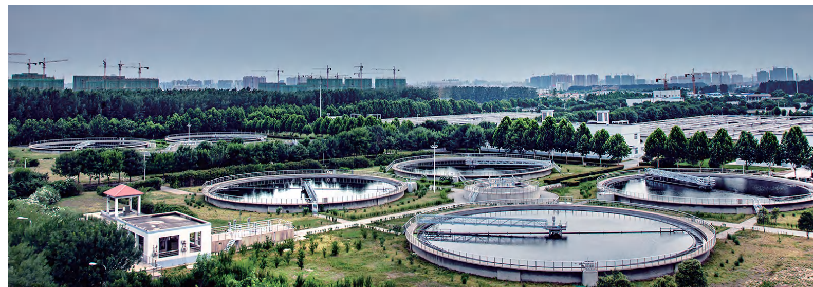
郑州市马头岗污水处理厂项目 Zhengzhou Matougang Sewage Treatment Plant
