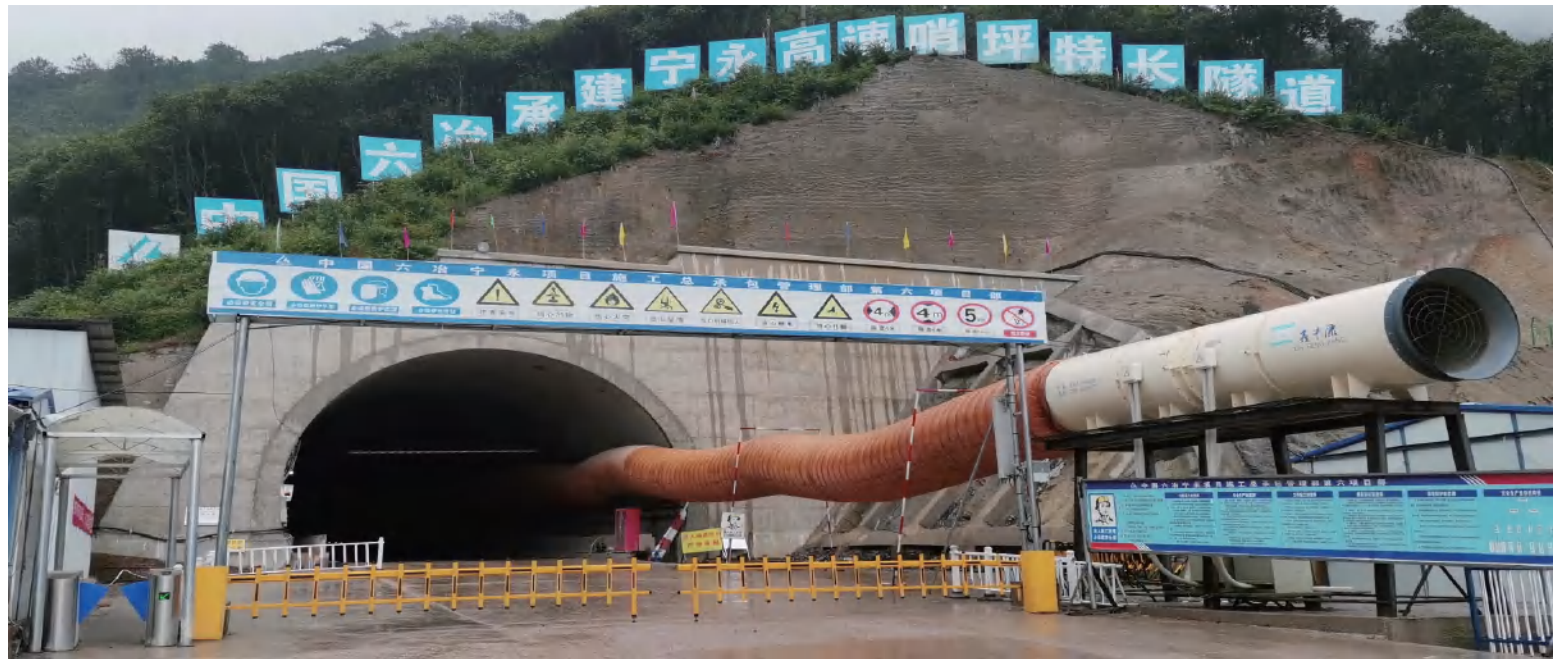
云南省宁永高速项目哨坪隧道长度5450米 Ningyong Expressway Project in Yunnan Province
