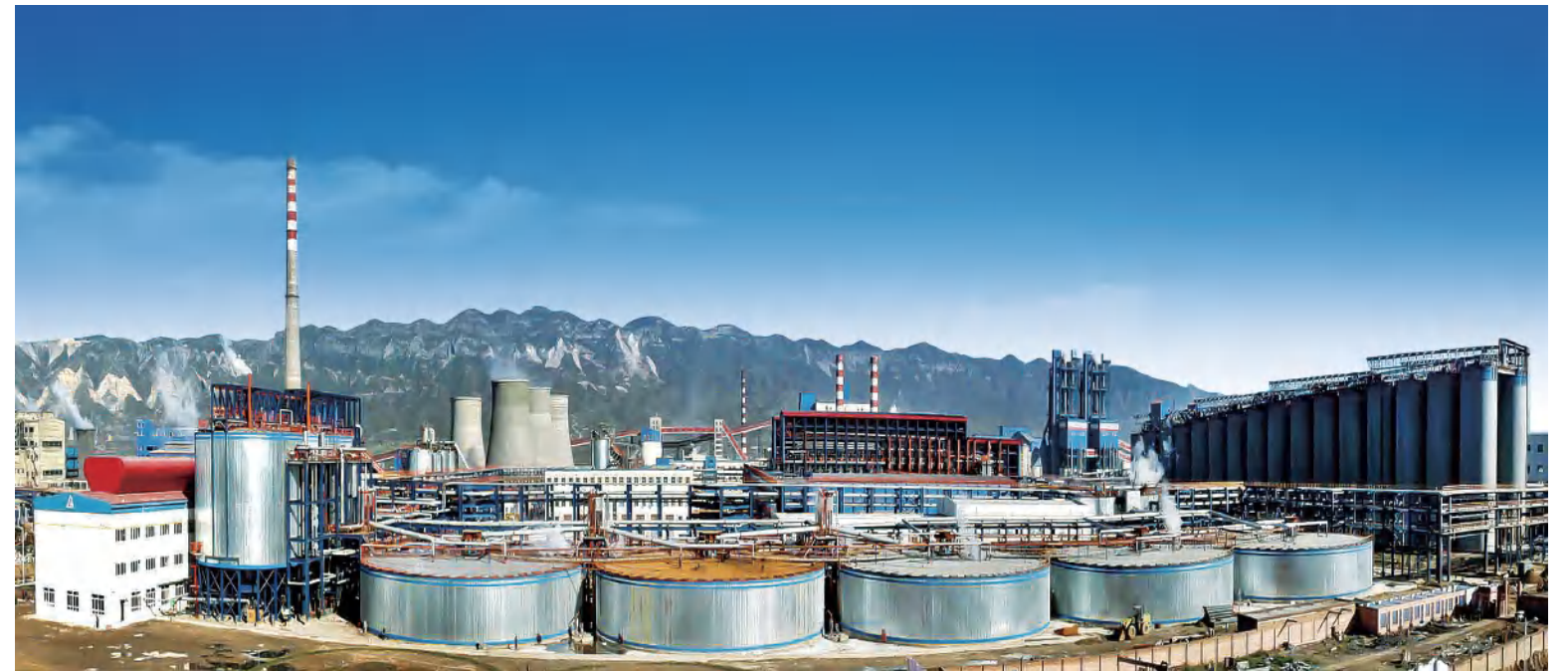
荣获国家优质工程银质奖 中铝山西分公司氧化铝项目 Alumina project of Chalco Shanxi Branch
