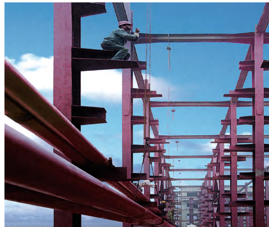
中铝中州铝业有限公司熔出二线钢结构 Chalco Zhongzhou Aluminum Co., LTD. Fusible second-line steel structure
