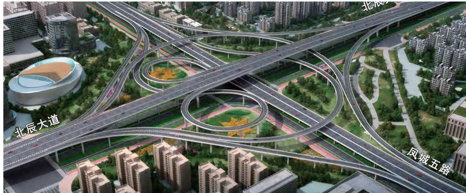
西安市道路钢箱梁项目 Xi'an Road steel box girder
