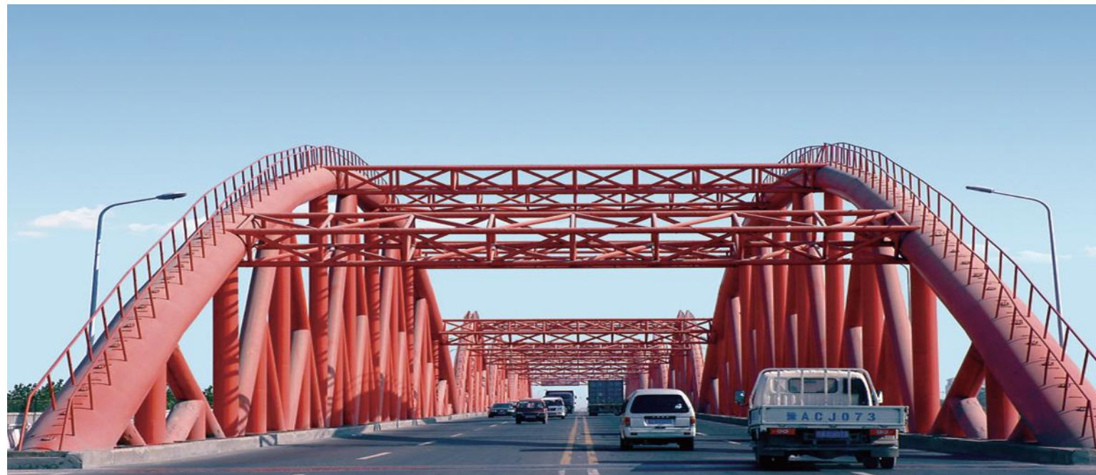
郑州市北环路跨铁路大桥——亚洲最大的跨铁路钢桥 Zhengzhou North Ring Road crossing railway bridge
