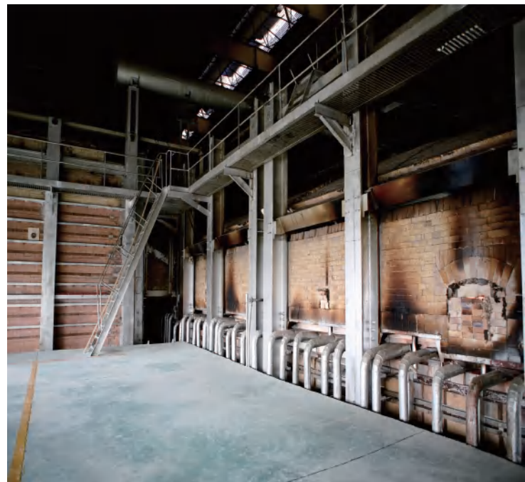
伊朗窑炉工程 Iran kiln project
