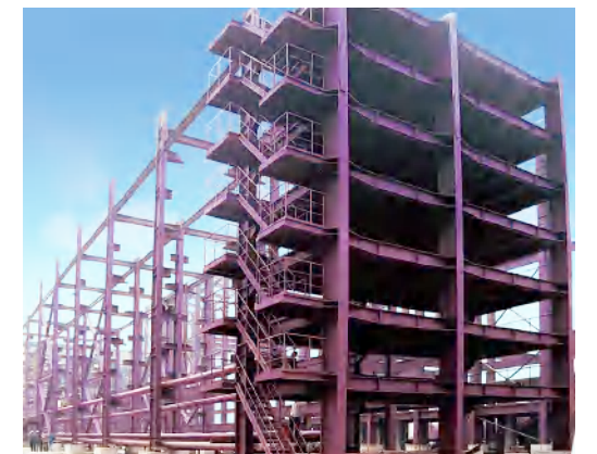
中州铝厂钢结构框架项目 Steel structure frame of Zhongzhou Aluminum Plant
