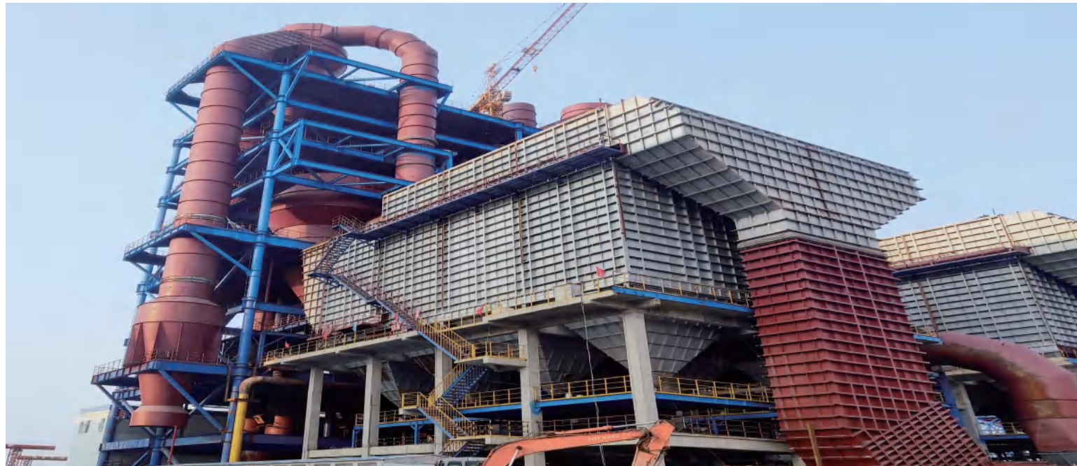
广西华昇氢氧化铝焙烧工程 Guangxi Huasheng Aluminum hydroxide roasting project
