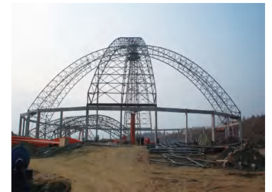
天瑞集团南召水泥厂项目 Tianrui group Nanzhao cement plant 中天环拱86米钢结构屋架安装工程
