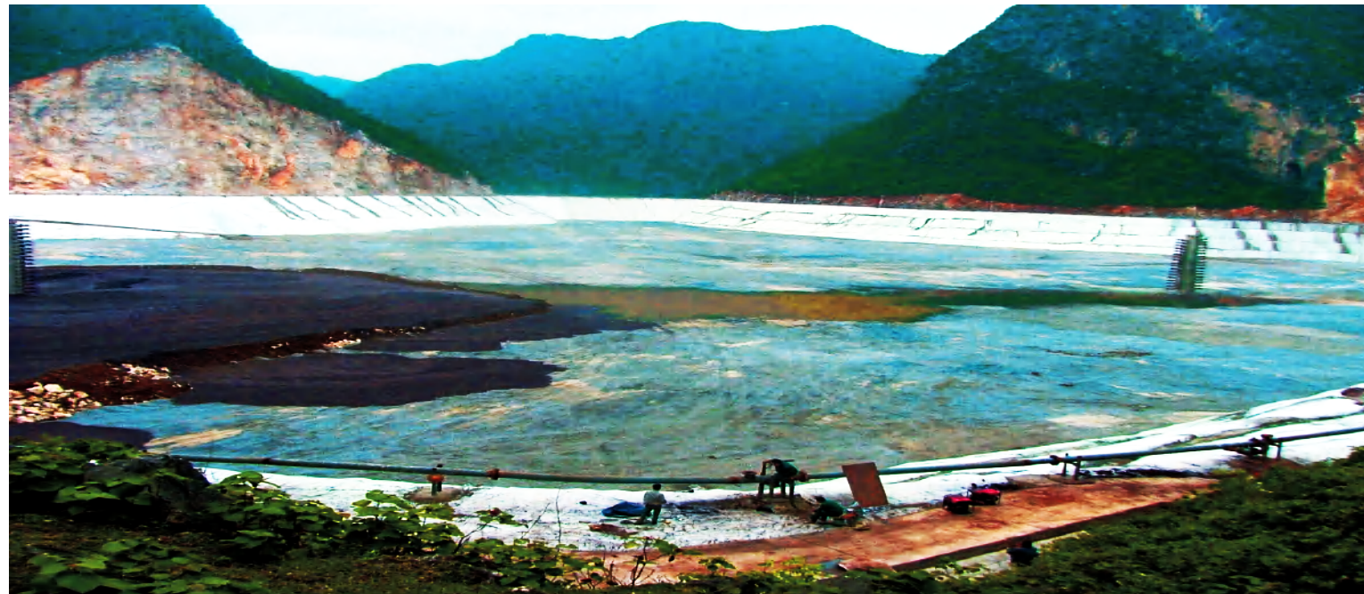
中国铝业广西分公司矿山排泥库 China Aluminum Guangxi Branch mine sludge warehouse
