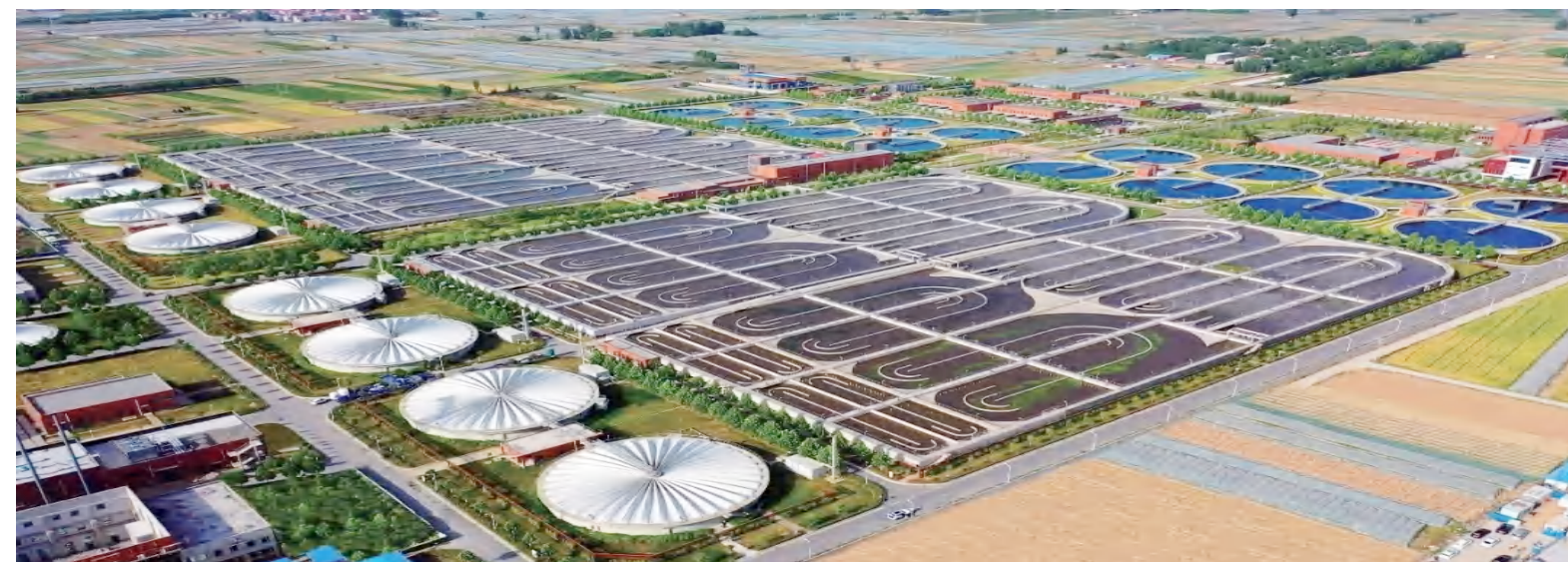
郑州市郑东新区污水处理厂项目 Zhengzhou sewage treatment plant project 河南省重点基础设施建设项目，建设规模为日处理污水65万吨，荣获国家优质工程奖、河南省工程建设优质工程奖等奖项
