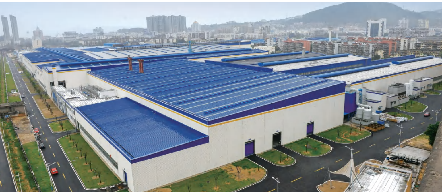
荣获国家优质工程奖 中铝瑞闽股份有限公司高精铝板带工程 High precision aluminum strip project of Chinalco Ruimin Co., LTD
