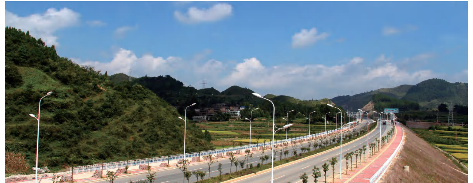
都匀173市政道路 Duyun 173 Municipal Road
