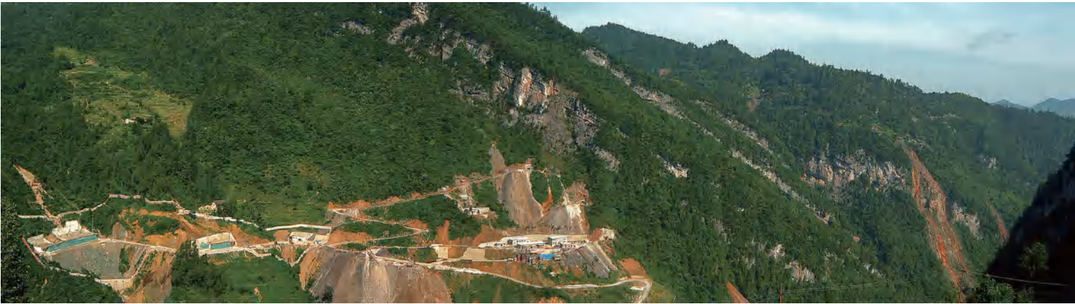
中铝重庆公司矿山工程 Chinalco Chongqing Mine project
