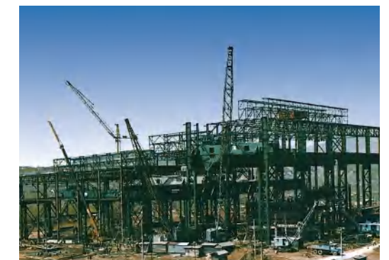
舞阳炼钢厂房钢结构项目 Steel structure project of Wuyang steelmaking workshop
