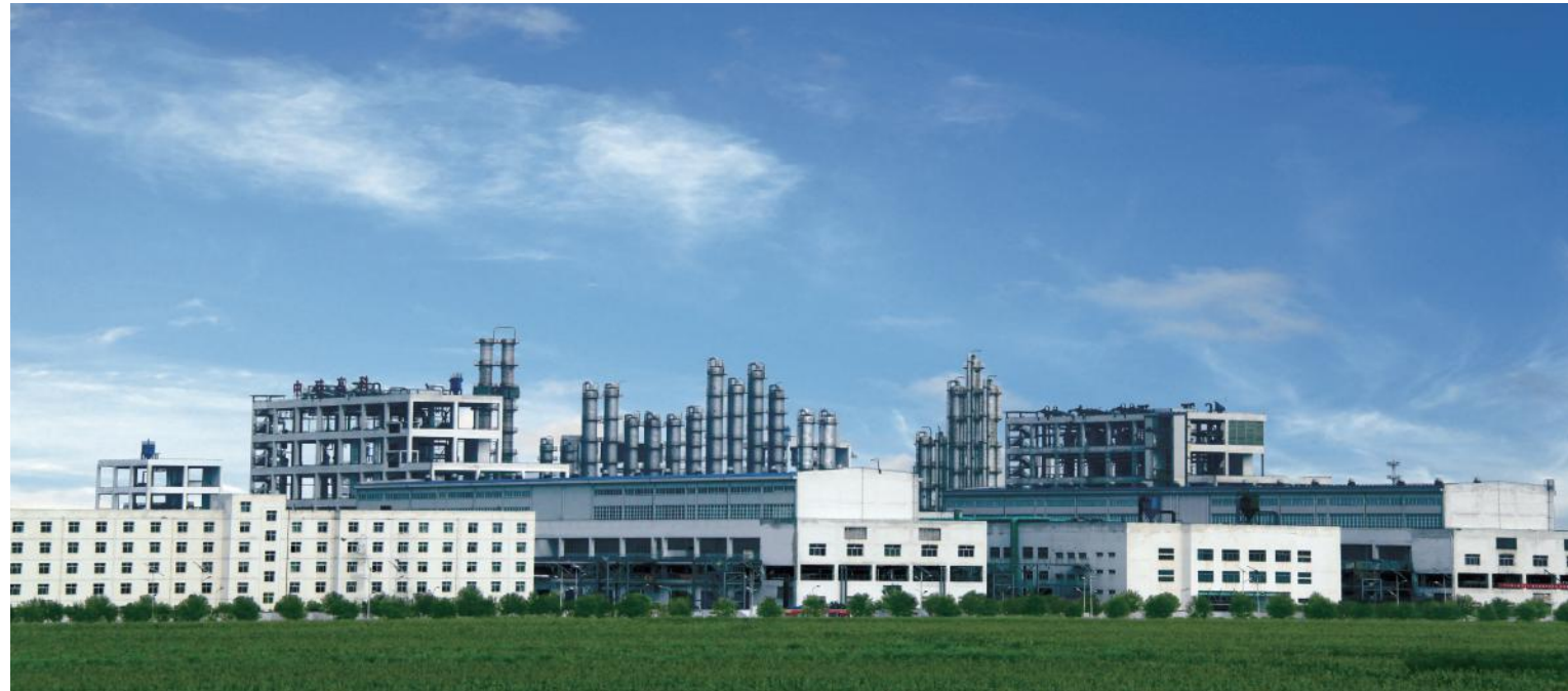
洛阳中硅项目 Luoyang Zhongsi Project
